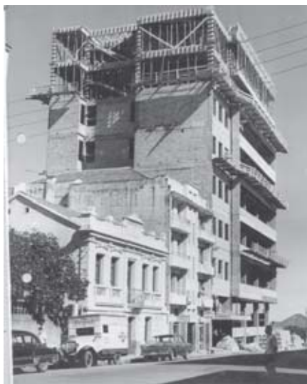
Prédio do Banco do Brasil em construção.
